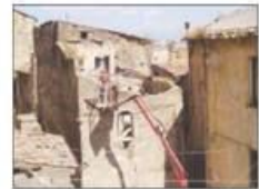
Le demolizioni in corso
